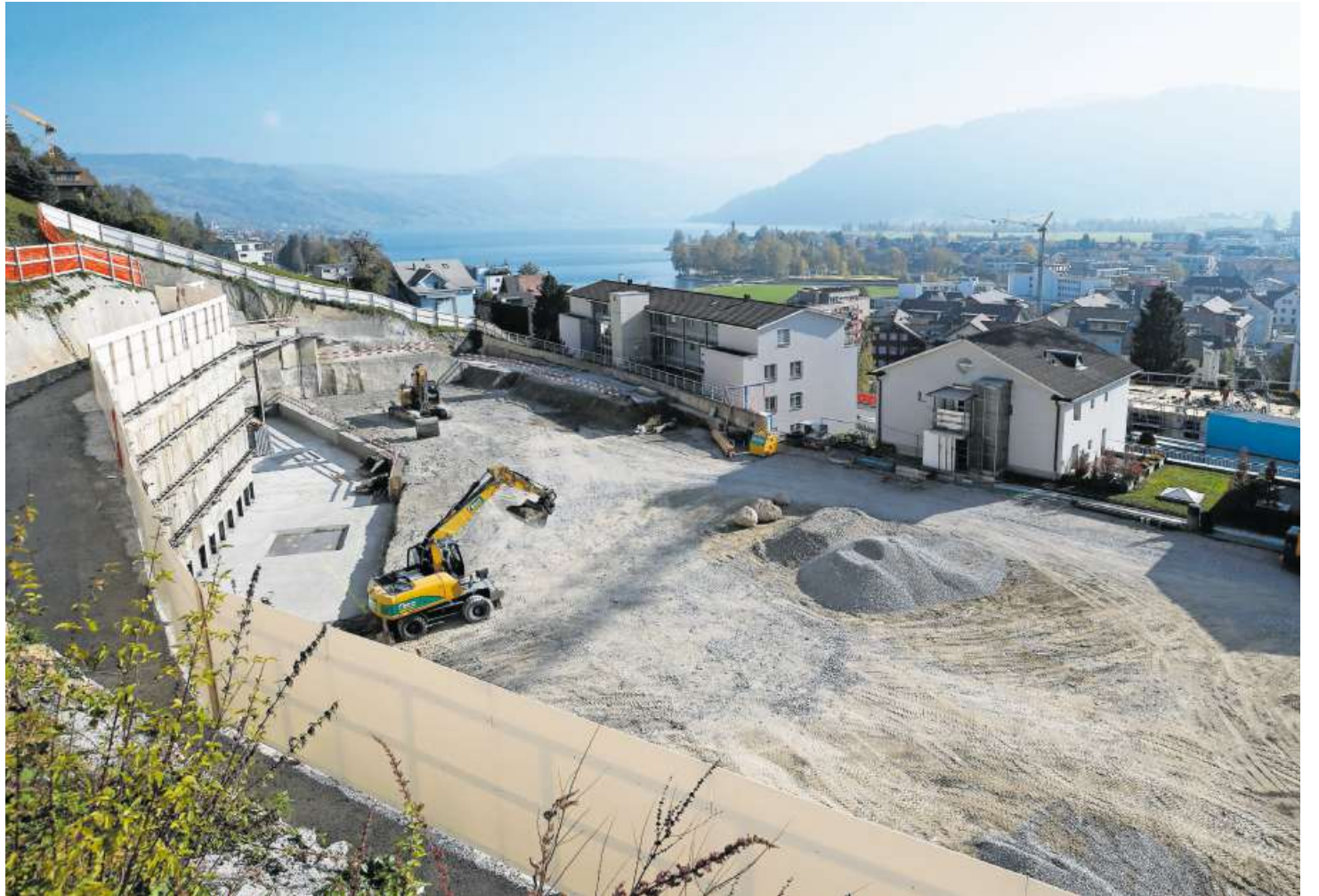
Baustelle für das Kinderhotel in Unterägeri. Hier sollen jetzt stattdessen Residenzwohnungen entstehen.
